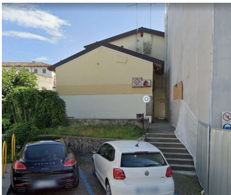
Fig.3 - Vista edificio da Piazzetta del Donatore
